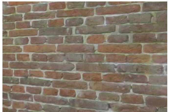
Veldovenbakstenen met de verschillende kleuren en afmetingen.
