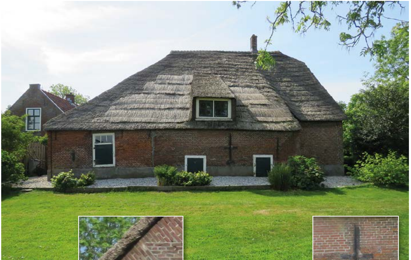
▲ De achterzijde met de kelderramen. Links het zomerhuis.
